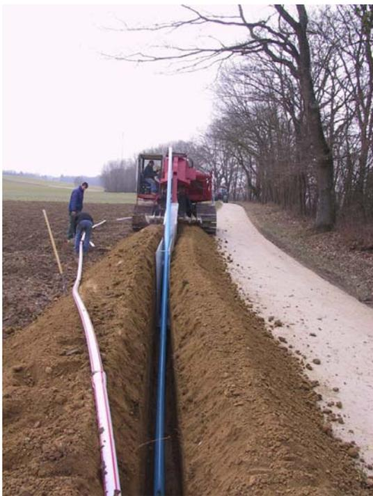
*Mit dem Grabenbagger werden die Förderrohre verlegt.*
