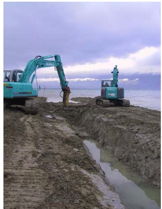
*Grabungsarbeiten für das Verlegen der Zuleitung, welche die Wasserfassung mit der Pumpstation verbindet*
