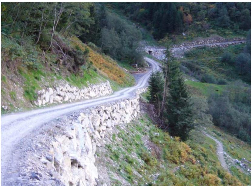
*Neue Linienführung mit aufwändigen Böschungssicherungen*
