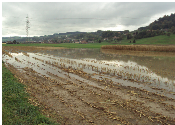
Vernässungen nach einem Niederschlagsereignis zeigen die Notwendigkeit von Massnahmen an den Drainagen auf
