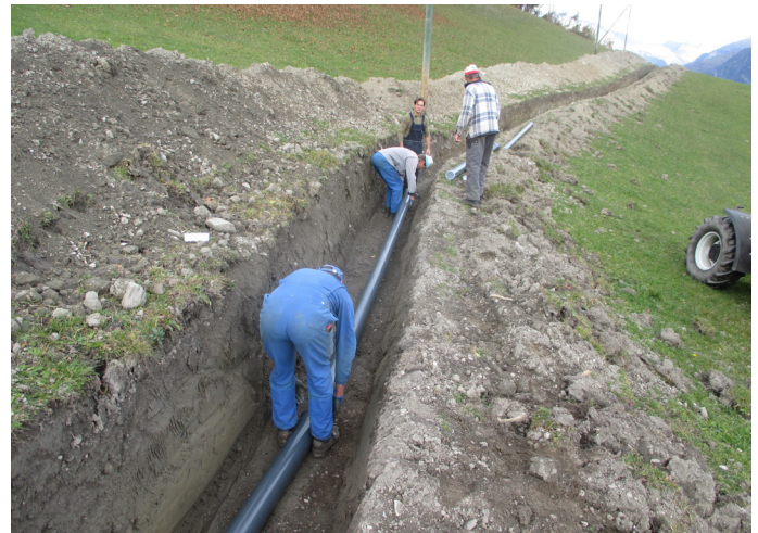
Verlegung der Rohre durch die Genossenschafter
