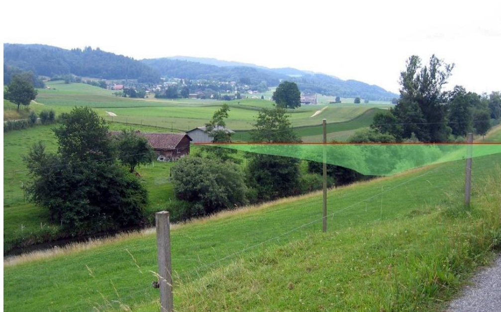
Blick auf den Standort des geplanten Hochwasserrückhaltebeckens (rote Linie) in der Gemeinde Staffelbach. Beim Bau lässt sich die Topographie der Endmoräne des Reussgletschers ausnutzen.
