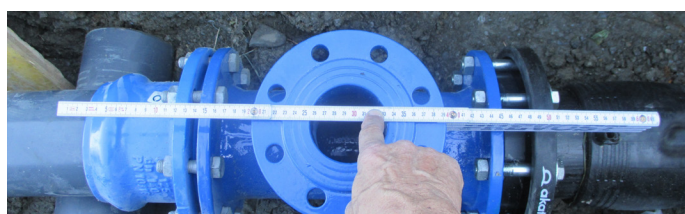
Mass nehmen für den Kontrollschacht
