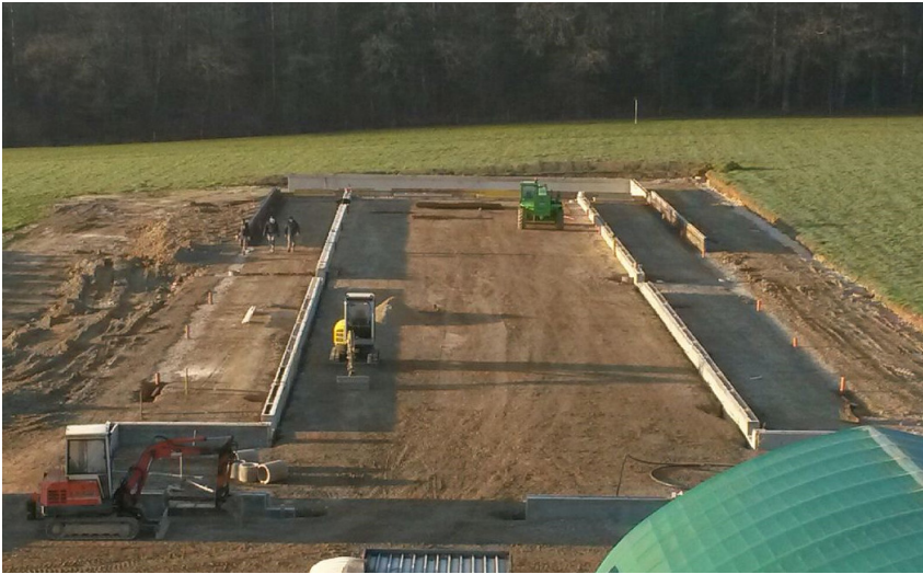
Construction du poulailler pour 12 000 pondeuses à Céligny
