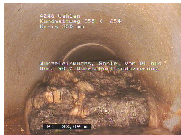
Wurzeleinwuchs wirkt sich negativ auf die Abflusskapazität der Drainageleitungen aus
