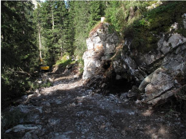
*Wegebau durch den Schiltwald im Herbst 2010. Die Wegführung wurde soweit möglich an die Gegebenheiten angepasst. Einzelne Felsblöcke mussten dennoch weggesprengt werden*
