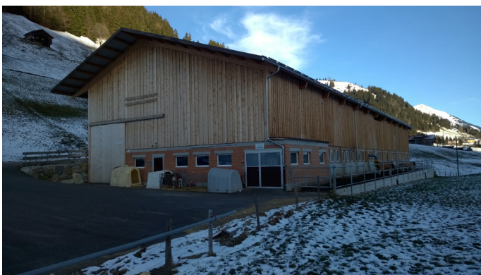
Le bâtiment s'intègre parfaitement à la morphologie du paysage
