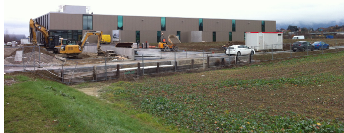
Nouvelle centrale maraichère de l'UMG: un investissement qui renforce la culture maraichère genevoise et l'intègre dans le développement de l'agglomération.
