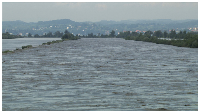
Das Rheinvorland bringt bei Extremwetterereignissen zusätzliche Abflusskapazität.
