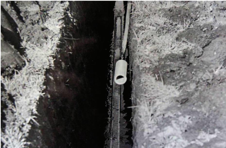
Abb. 11: Setzen von Drainröhren auf die vertiefte Grabensohle. (Bildarchiv der Melioration der Rheinebene)
