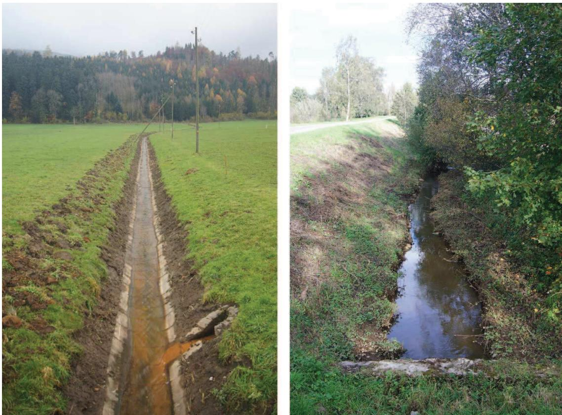
*Abb. 26: Links ein Graben mit Betonhalbschalen in der Kobelwies, rechts der revitalisierte Mittlere Seegraben im Bannriet zwischen Altstätten und Oberriet. Die Betonhalbschalen wurden entfernt und eine Kiessohle eingebaut. (Bilder: Nicole J. Seitz)*
