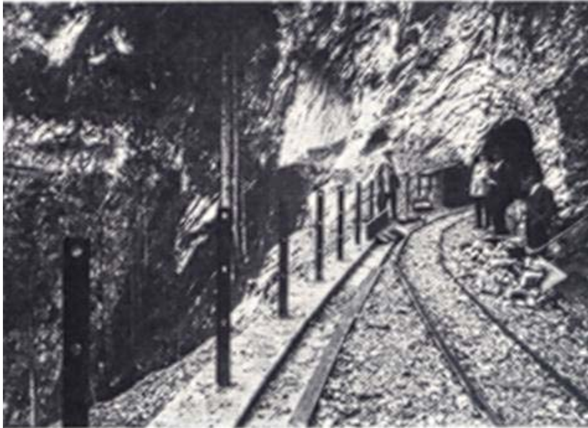
1926 Straßentunnel am Bergweg Weißenburgberg, Gemeinde Därstetten.
