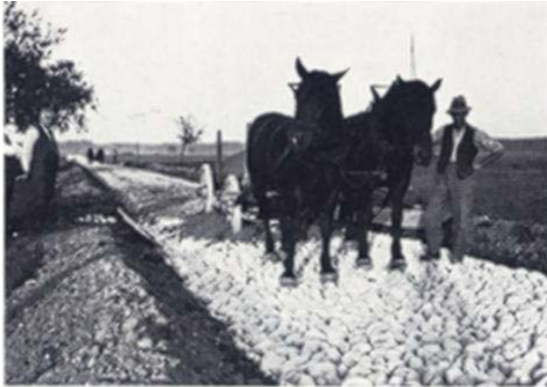
1930 Güterzusammenlegung in Utzenstorf, Wegebau.
