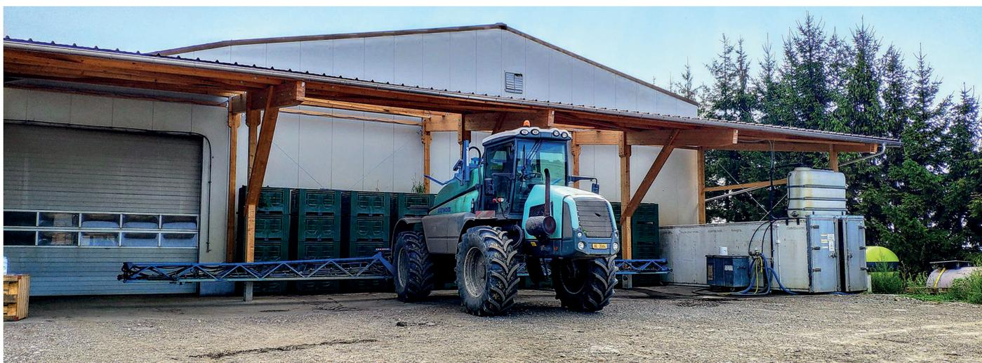
Füll und Waschplatz mit Verdunstungsanlage (Biobed) in Paloxen, Schlammsammler unter Spritze, rechts Puffertank für Waschwasser
