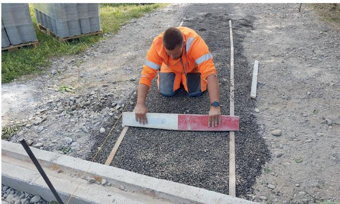
Vorbereitung der Versetzung der Rasengittersteine (man beachte das negative Dachprofil der Planie der Spur zur Ausbildung einer wasserführenden Rinne mittig der Steine)
