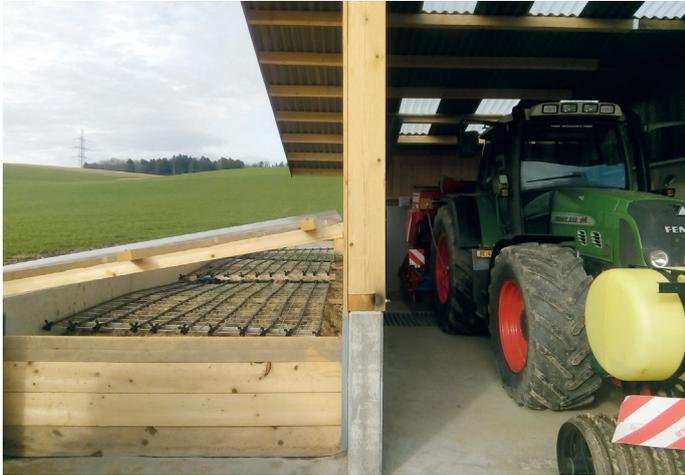
Füll und Waschplatz (rechts) mit Verdunstungsanlage (Biobed) in „Fahrsilo“-Form (links), Schlammssammler und Puffertank unterflur.
