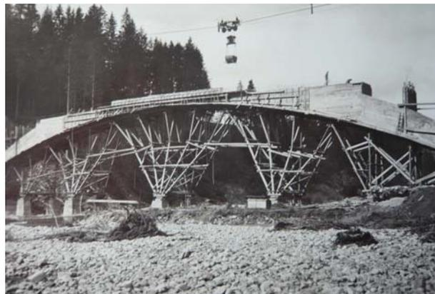
*Construction du Pont du Rossgraben, avec échafaudage et téléphérique de chantier (10 octobre 1932)*
