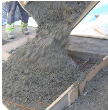
*Comme ici à Scheid (GR), les treillis d'armature protègent le béton contre les contraintes de traction et réduisent les quantités de béton à transporter.*
