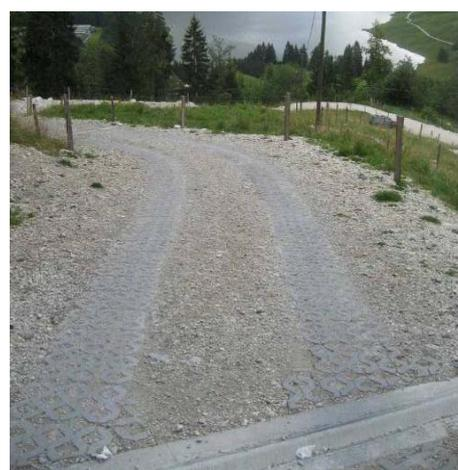
*Chemin d'accès à l'alpage de la Breccaschlund (Lac Noir FR) en bandes de roulement avec des pavés ajourés en béton et des éléments préfabriqués (au premier plan) pour l'évacuation des eaux de surfaces.*
