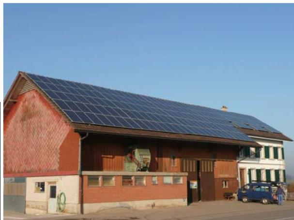
Des 161 modules d'une puissance de 180 W, composés, chacun, de 50 cellules solaires polycristallines, il en résulte une installation photovoltaïque compacte installée sur le toit de la grange et de l'habitation, développant une puissance intéressante.
