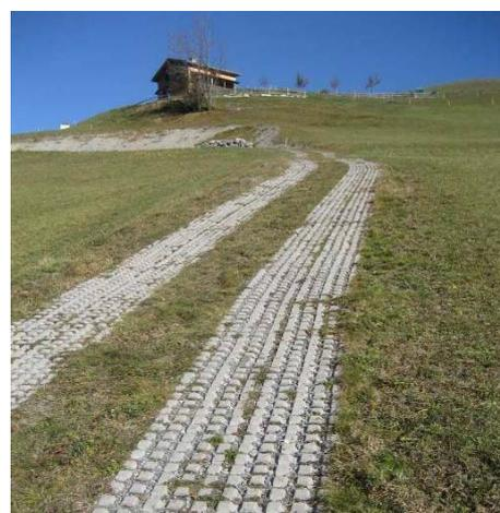
*Les bandes de roulement en pavés ajourés en béton se prêtent aussi pour des chemins d'exploitation à très forte pente, comme ici à Valendas (GR).*
