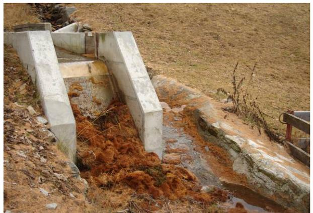
*Aménagement moderne d'un petit captage à partir d'un bisse, destiné à alimenter une installation fixe d'irrigation*
