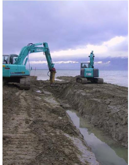
Lavori di scavo per la posa della condotta d'alimentazione che collega la presa d'acqua.
