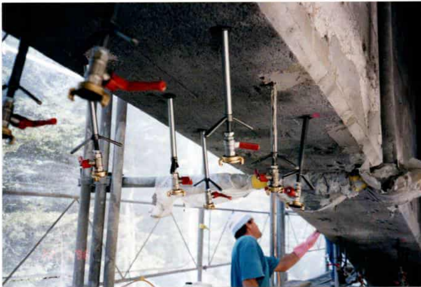
Vorbereitung der Injektionen mit Feinst-zement mittels setzen von Lanzen (Bohren war wegen Armierung schwierig)
