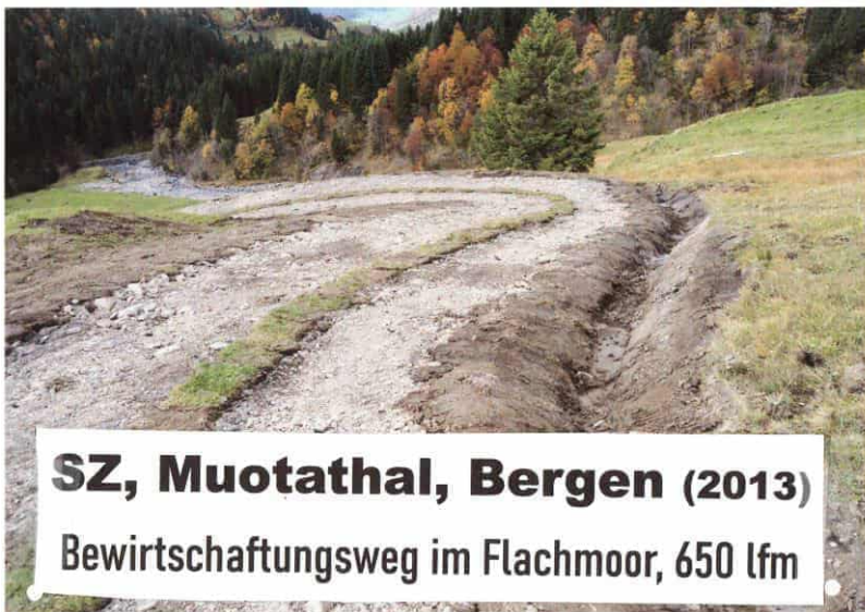
Einsatz von Holzschwarten (evtl. längs und kreuzweise verlegt) direkt auf Erdplanie (ohne Vlies oder Folie)
