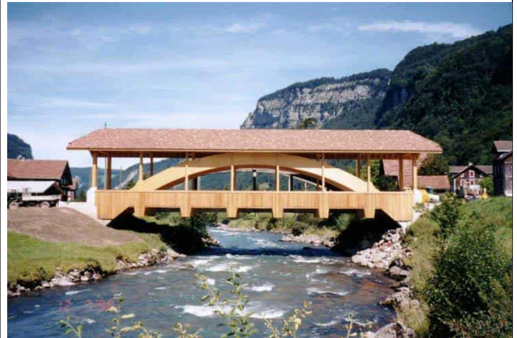
Gedeckte Holzbrücke im Ried-Muotathal, 30 m, 40 t (siehe suissemelio homepage)
