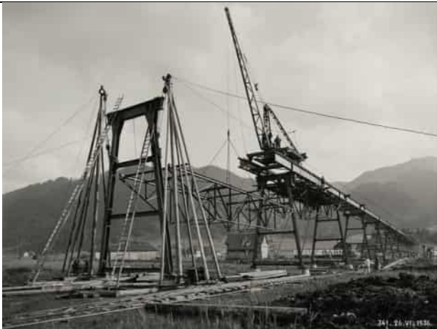
Bau der Sihlseebrücke auf schlecht tragfähigem Untergrund mit Holzpfählung
