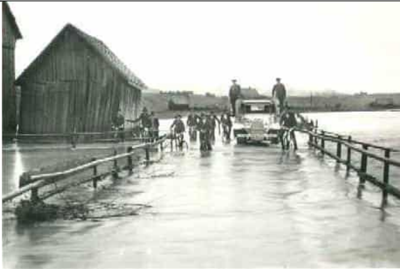
Zügeln im letzten Moment (während Stauvorgang), das Gebäude steht noch!
