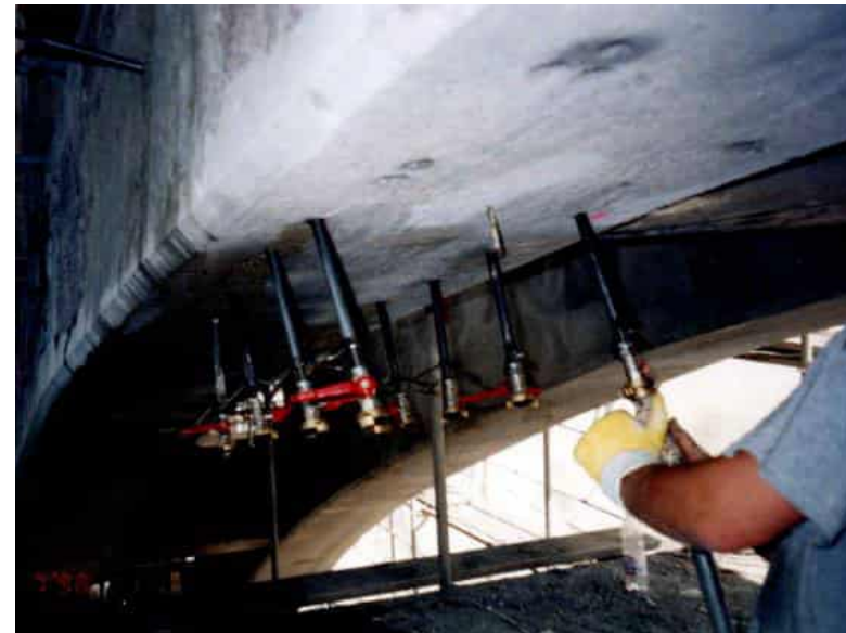
Mit sehr grossem Druck wird der Zementmörtel in die feinen Hohlräume des Betonbogens gepresst (Nahrung für die rostenden Eisen!)
