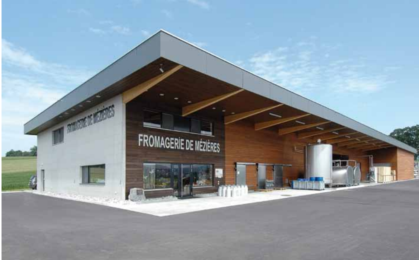
Neue Käserei der fusionierten Käsereigenossenschaft Mézières und Umgebung mit dem Verkaufslokal vorne, der Annahme und Milchverarbeitung in der Mitte und dem Käsekeller hinten. Aspekte wie moderne Architektur, hohe Funktionalität des Gebäudes und angemessene Erweiterungsmöglichkeiten wurden optimal vereint.
