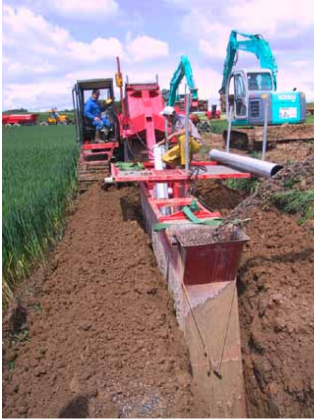
Die heutige Technik ermöglicht kompakte und rasche «Alles in einem»-Bauten. Hier wird eine Sammelleitung mit einer «Fräse mit gleitender Spriessung» verlegt.
