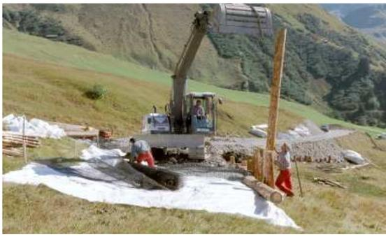
Attraversamento di una torbiera bassa con la realizzazione del corpo stradale con sottofondo in legname rotondo e vetro multicellulare
