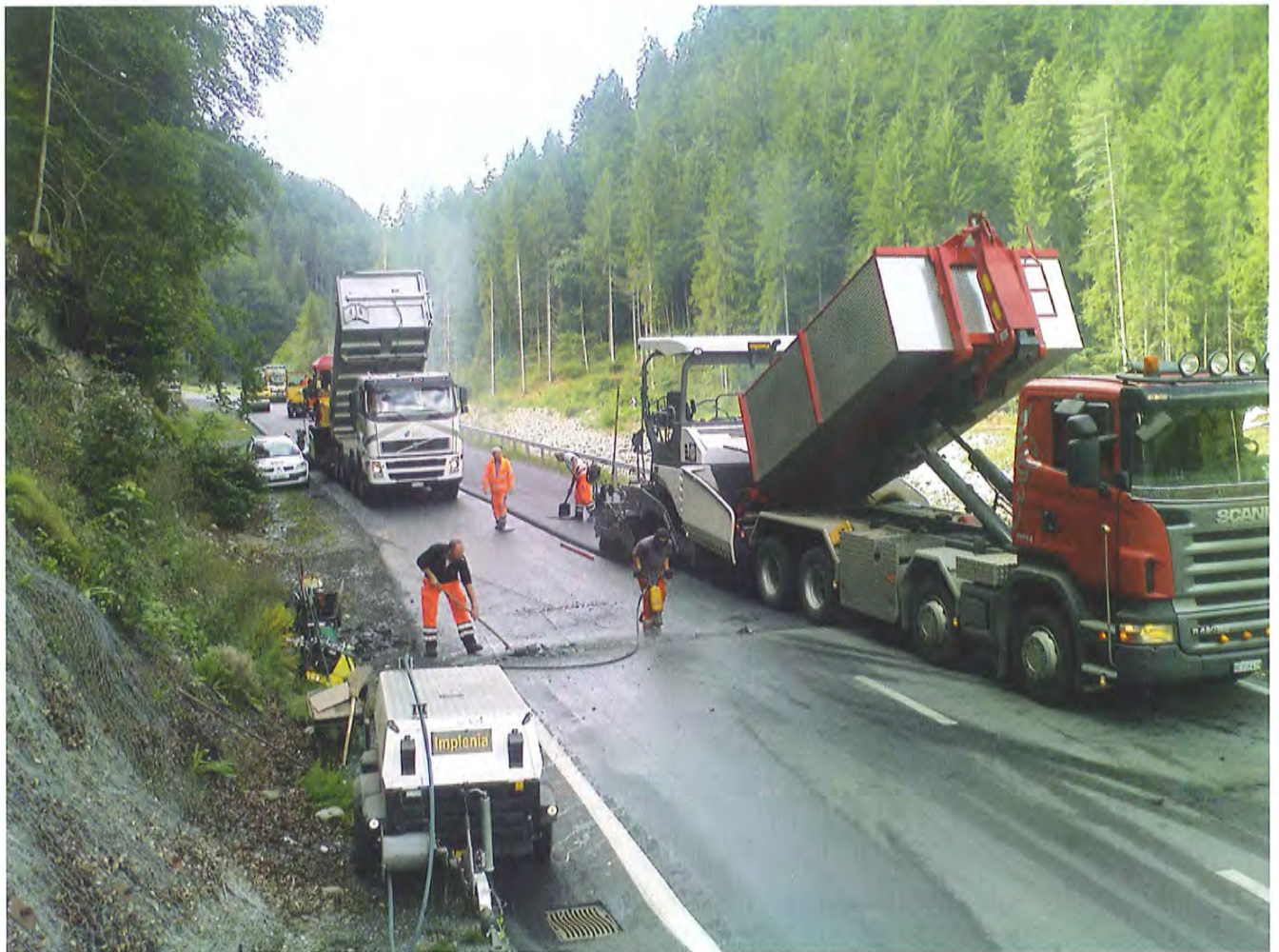
Einbau des Deckbelages auf der Kantonsstrasse im Spätsommer 2009.
