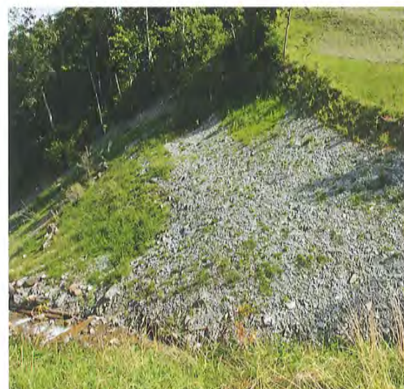
Oben: Abriss auf der rechten Bachseite.
